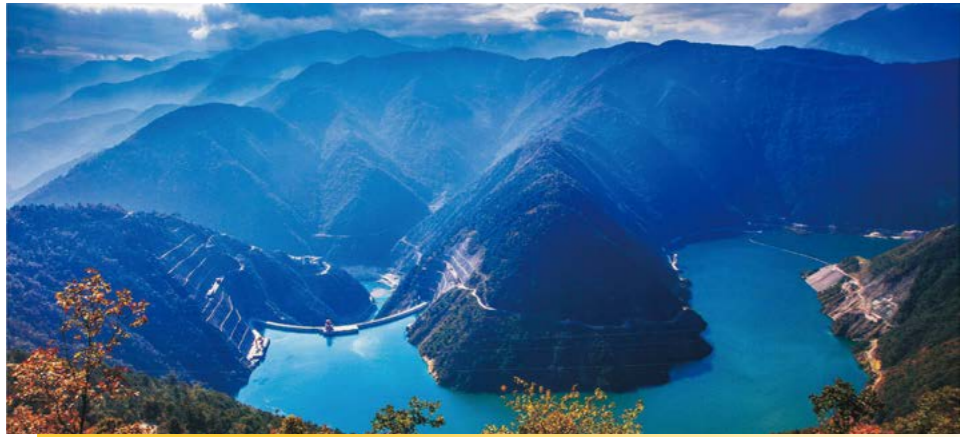
大渡河大岗山水电站
