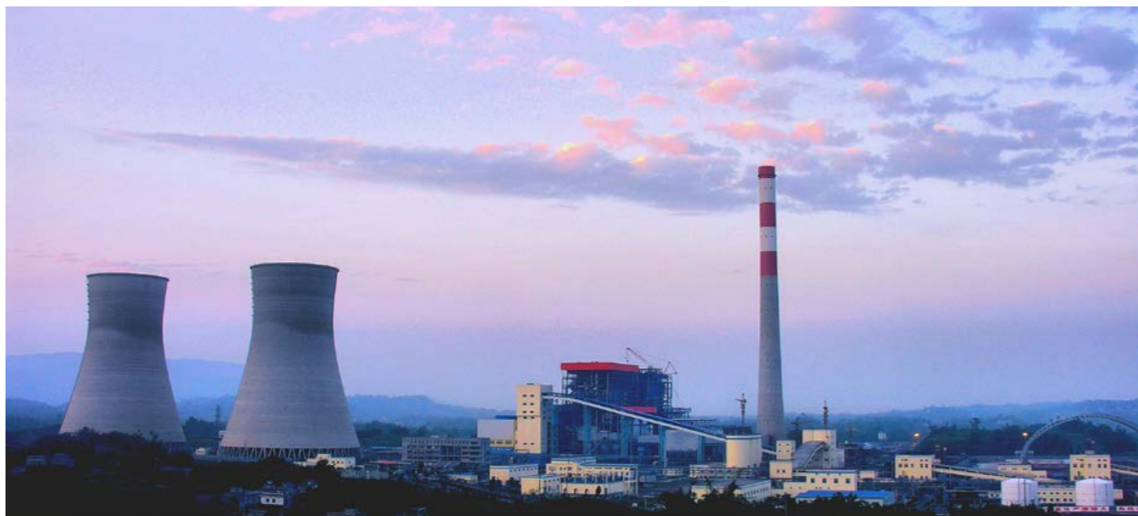
装机容量 120 万千瓦——川南发电公司
